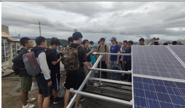
太陽能發電系統設施進行現地說明
